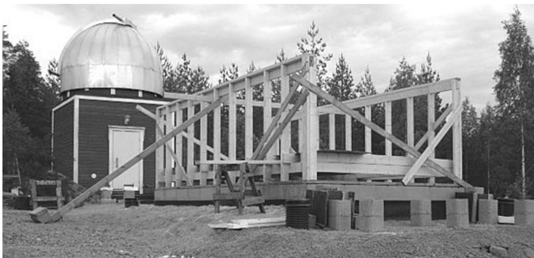
Kuva: Katselutasanteen runko nousemassa 1.6.2016. Etualalla näkyvät pilarit ovat invaluiskaa varten. Teräksiset kattorakenteet odottavat maalattuina tornin vieressä vasemmalla.
